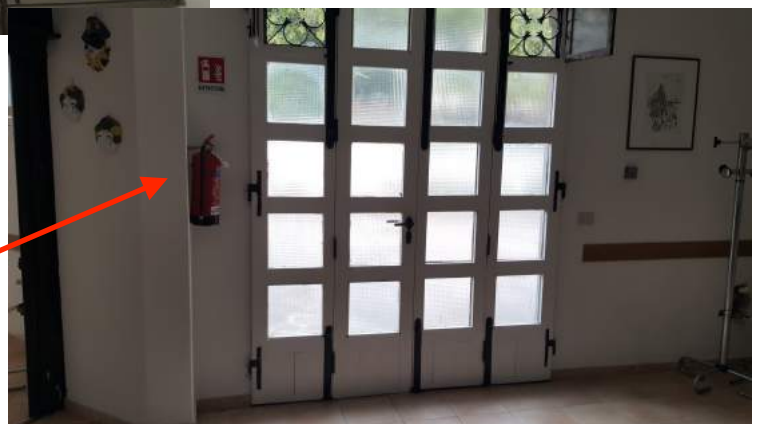
SALA CUCINA (PIANO TERRA ESTERNO)
